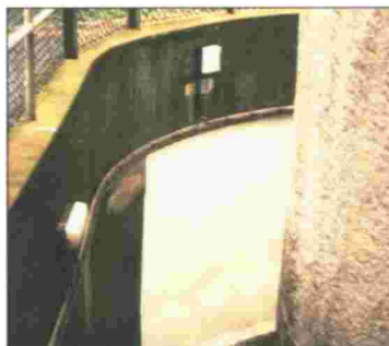
MUROS DE CONTENCIÓN
